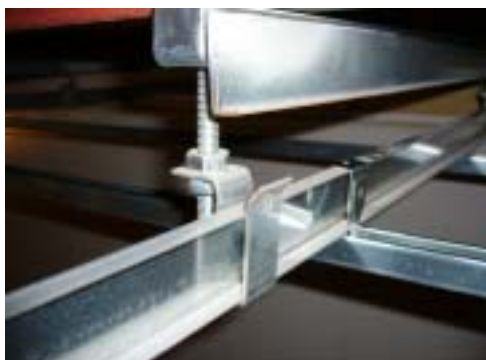
写真 4 クリップの施工写真(1)
