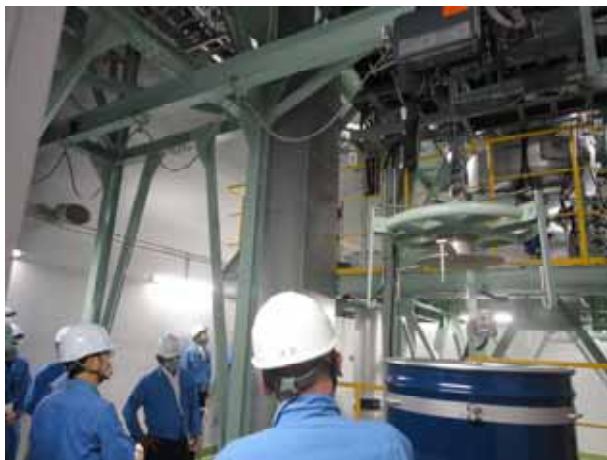
(立入りの様子：第2期施設 固形物搬送装置)
